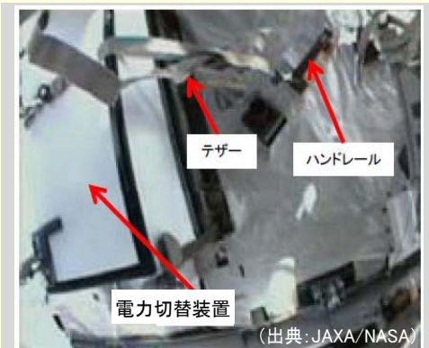
S0トラスへの電力切替装置のテザーによる固定
