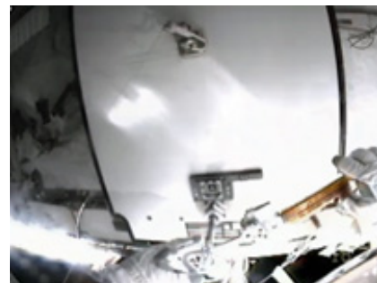
電力装置のボルトの締結を行う様子
